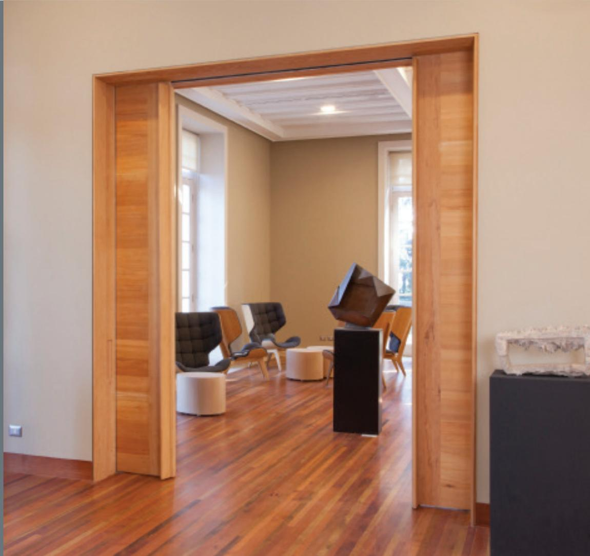
Sistema para la apertura de dos puertas sincronizadas con apertura en sentido opuesto.
