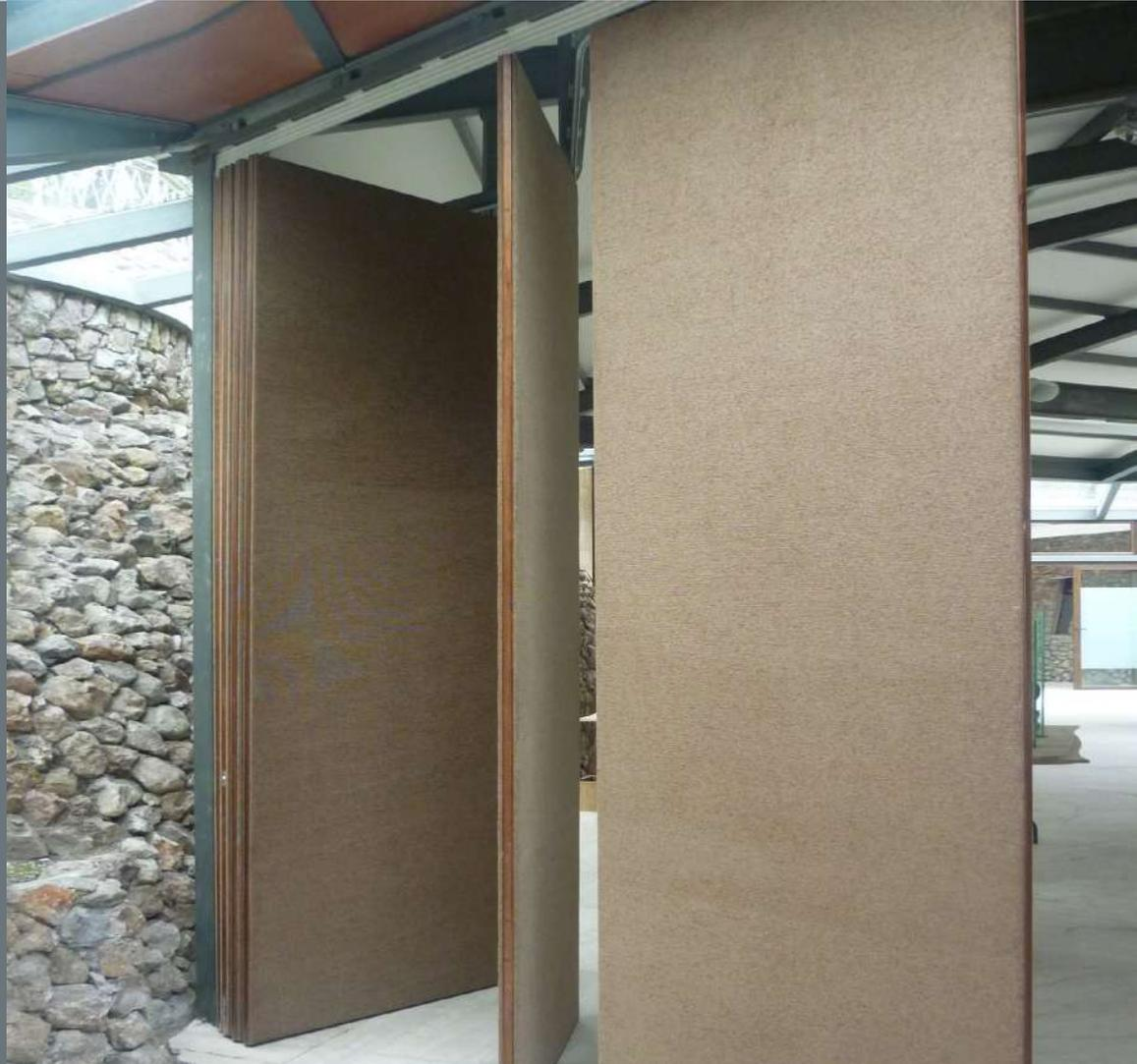
Sistema de herrajes ocultos para puertas apilables de madera de hasta 120 kg, que permite una apertura total del vano.
